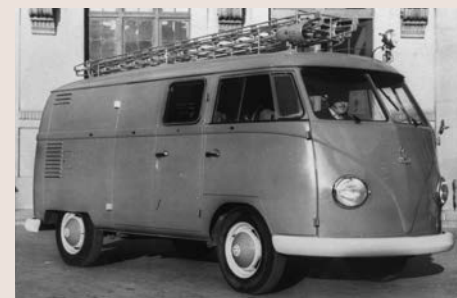
W BT 19 1955. Adquisición de 1955. Furgoneta Volkswagen T1 equipada por la empresa Rosembauer con una bomba de alta presión para apagar pequeños incendios. Se utilizó en el cuartel interior de la Feria de Muestras de Barcelona. ABB. El vehículo en la exposición pertenece a la colección privada Marcos Navarro.
