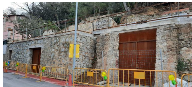
Arranjament de façanes i condicionament de locals
