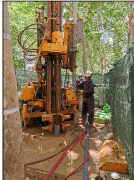
Perforació prèvia, instal·lació i lectura instrumentació profunda de terreny
