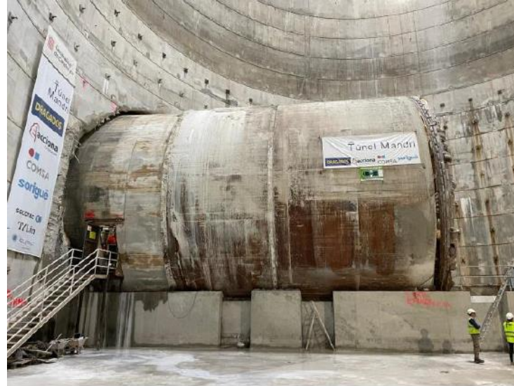
TBM a l'interior del pou de Mandri
