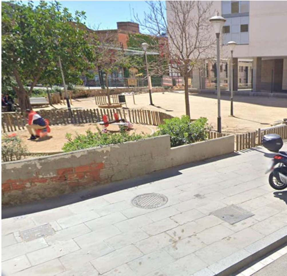
Paviment de peça de formigó prefabricada
