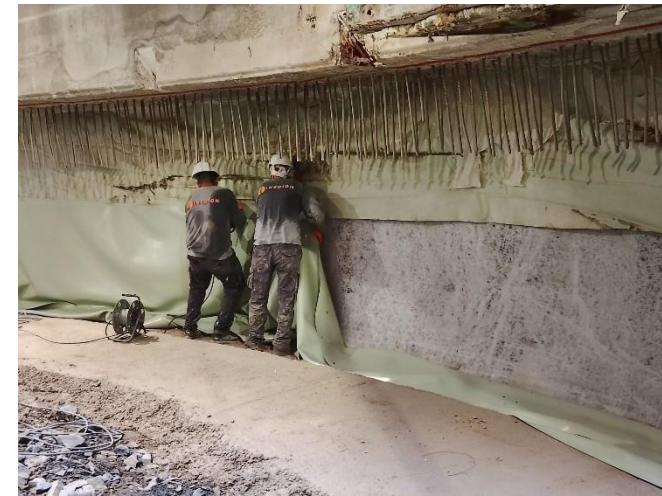
4. Col·locació làmina impermeabilització
