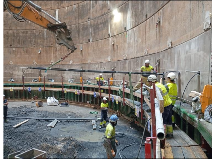
12. Execució ancoratges actius anell anterior
