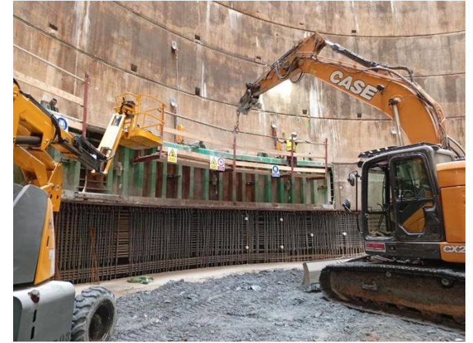
7. Desencofrat anell anterior
