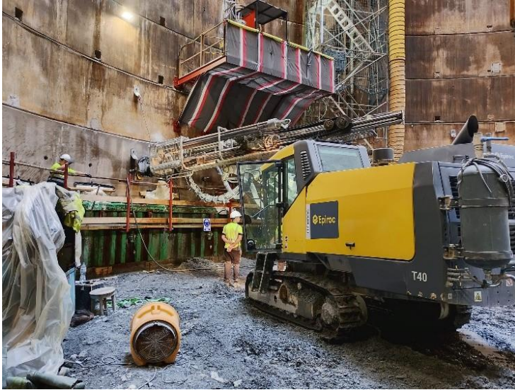
11. Perforació ancoratges actius anell anterior
