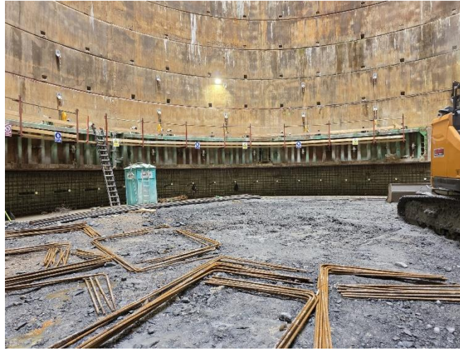
6. Armadura anell i col·locació baina ancoratges actius
