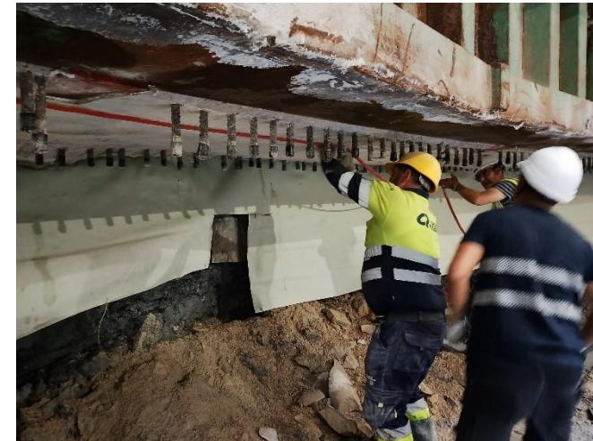
2. Col·locació junta hidroexpansiva
