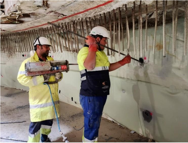
5. Execució ancoratges passius
