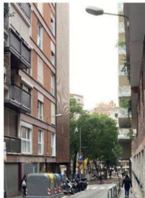
Enllumenat a façana
