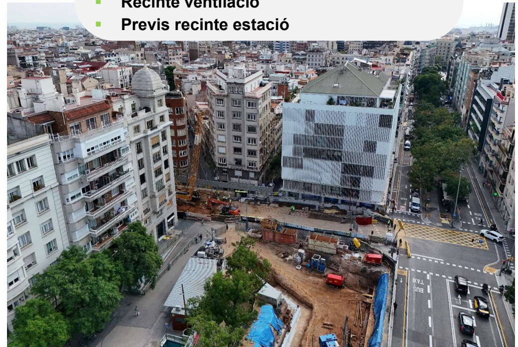
Imatge zona intercanviador i Travessera Gràcia. Data des'25
